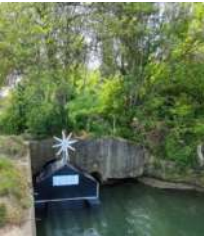
L'Echo cube, installé dans le cadre des défis berges, collecte les déchets flottants
