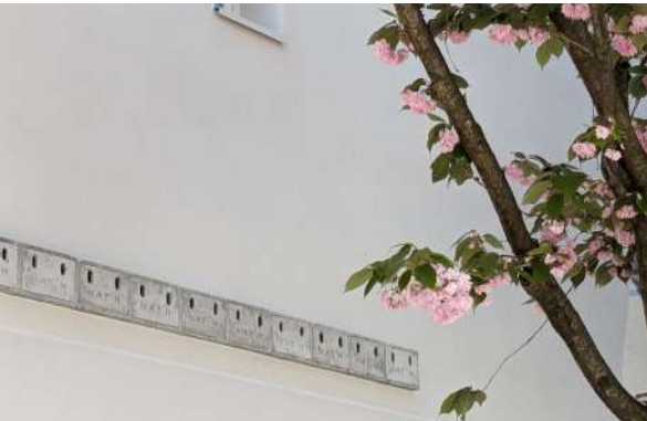
Nichoirs intégrés au bâti rénové
