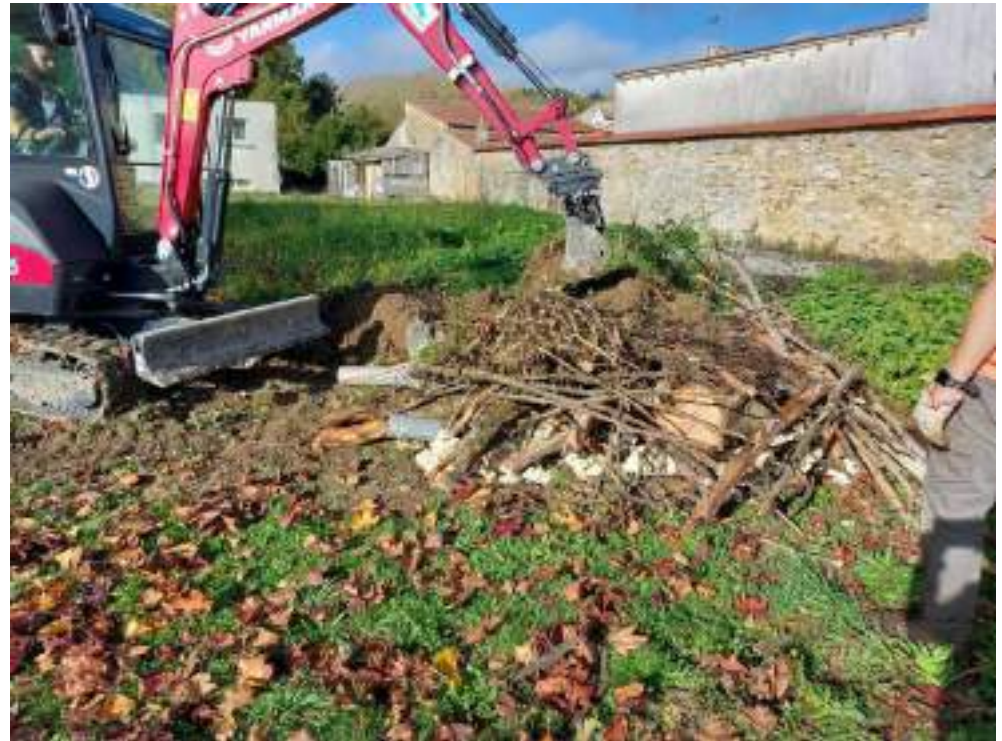
Construction d'un andain © L. Berger O.G.E.
