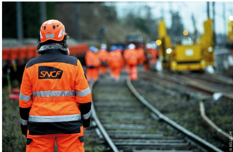
Perturbation du trafic ferroviaire à cause de gros travaux sur un aiguillage réalisés par SNCF Réseau - archives
